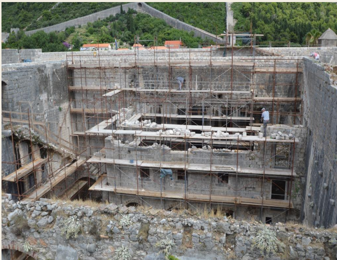
Veliki kaštio, tijekom sanacije
