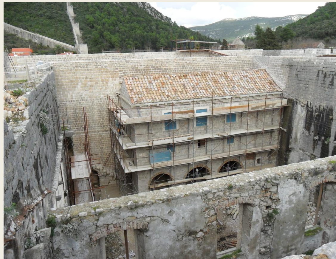
Kaštelanova kuća, rekonstruirano pročelje i krovšte
